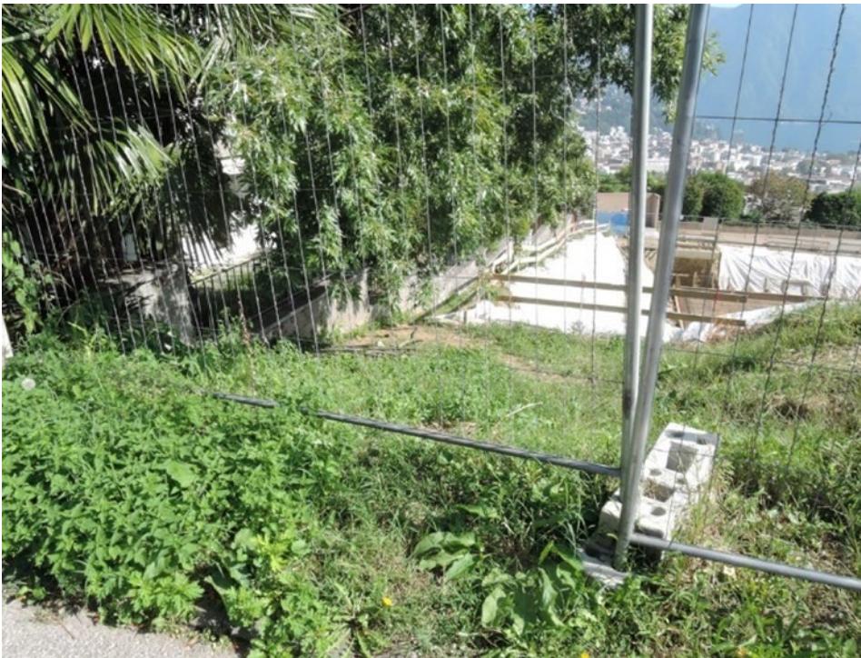
Fotografie 1 e 2: zona d'intervento
